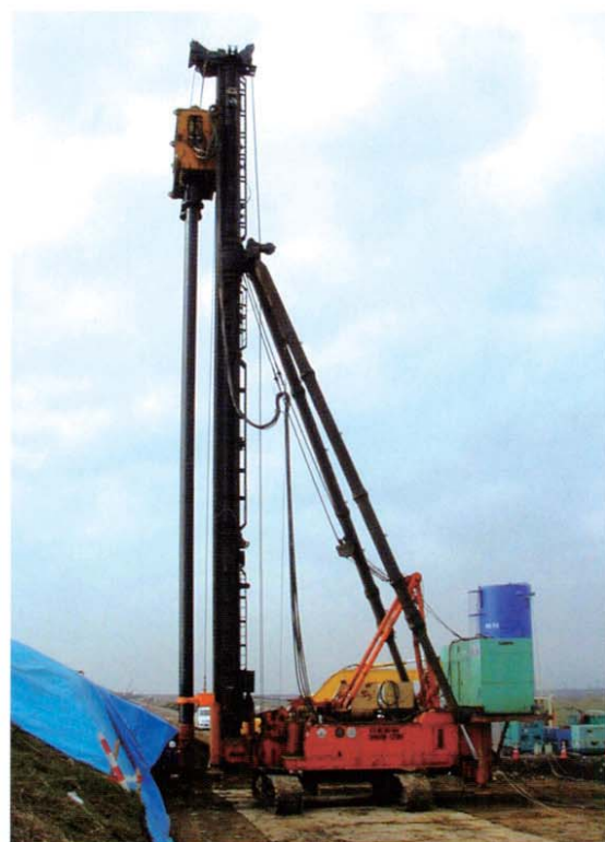
大型機による大深度施工、樋門基礎工事 (DM202型)
