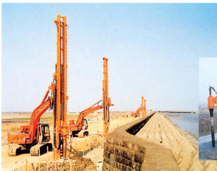
長尺機による堤防改修工事 (DM070型、特殊仕様機)
