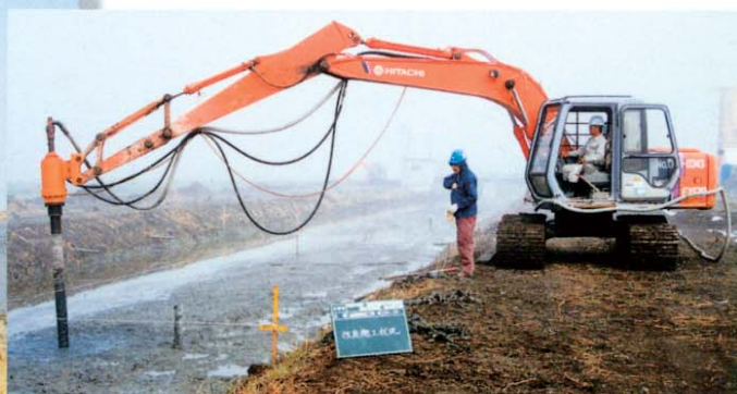
軽量機による河川改修工事 (DM045型)
