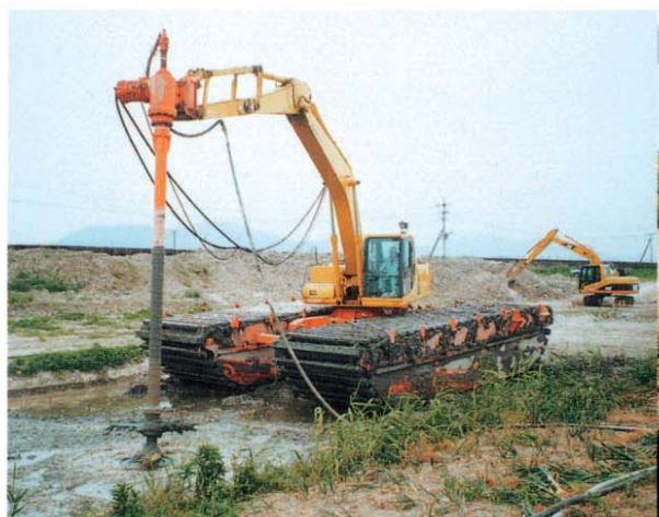
泥上車タイプによる河川改修工事 (DM070-M型)
