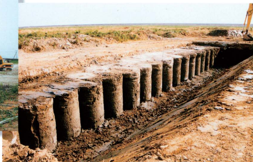
改良杭出来形状 (試験施工における杭出来形)
