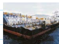
● 取水管敷設船
