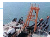
● 取水管敷設状況
