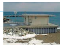
● 取水ポンプ室全景
