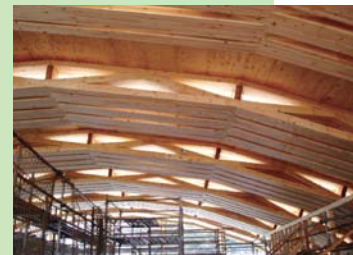
トラス組 施工中
