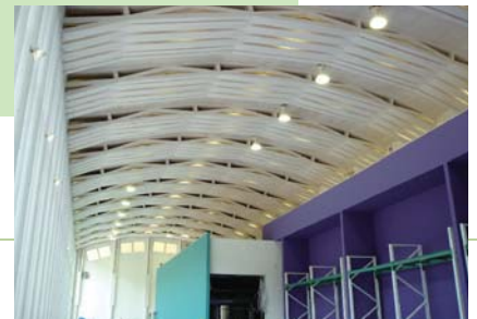
トラス組完成
