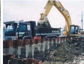
バックホウ掘削
