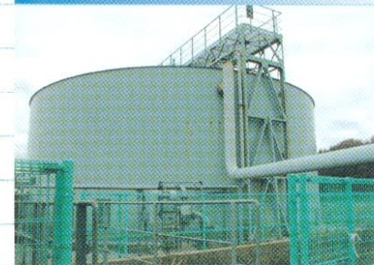
浚渫土を一旦貯泥します。
