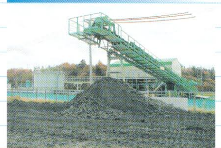
脱水処理された浚渫土は、護岸埋立等に有効利用されています。
