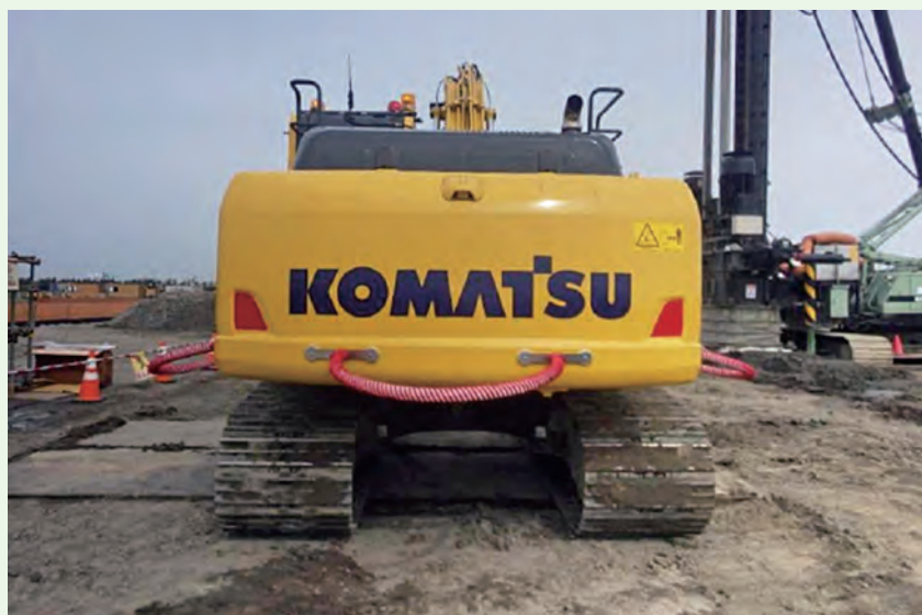
接触防止措置取付例
