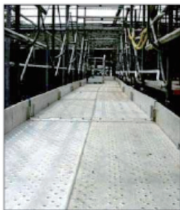
床付き布わく複数枚敷きによる解消例
