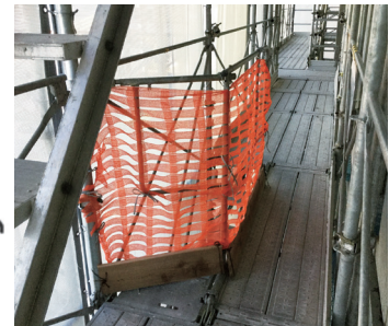
階段開口部手すりのすき間を塞いだ例
